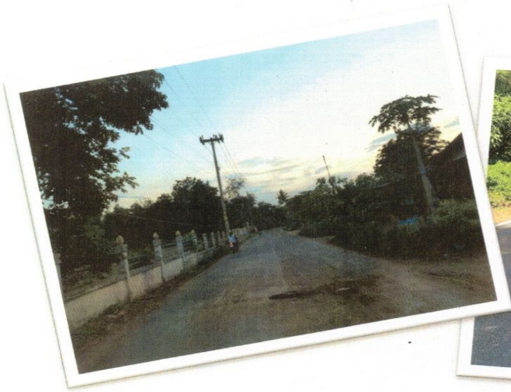
ปรับปรุงซ่อมแซมผิวจราจรบ้านดงกระทิง
