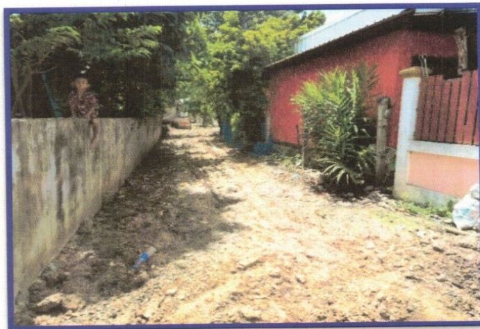
โครงการซ่อมแซมถนนหินคลุกบ้านโนนขวาง
