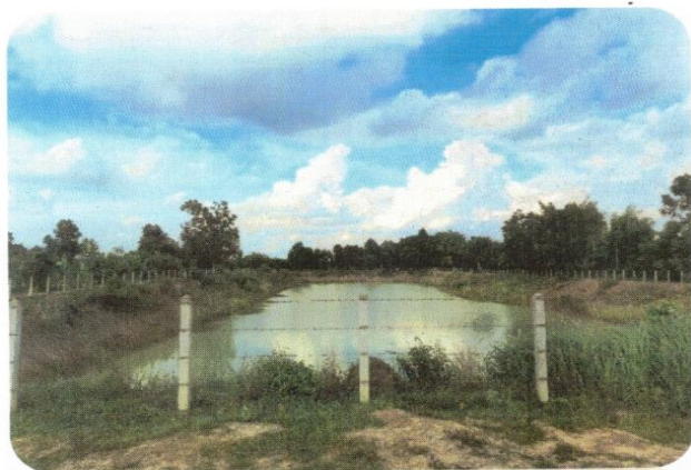
โครงการก่อสร้างธนาคารน้ำใต้ดินบ้านปอหู
